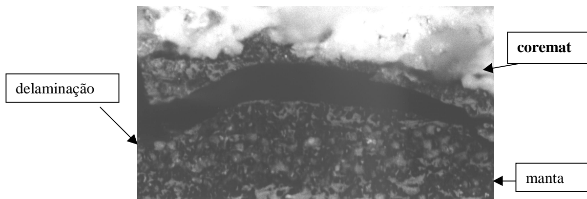
Figura 3- Delaminação na interface manta/coremat - placa sandwich CSH
